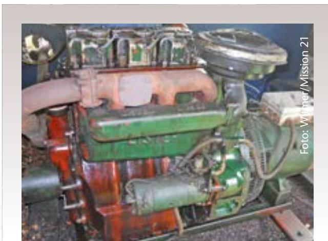
Der Dieselgenerator sorgt bei Stromausfall für Energie.
