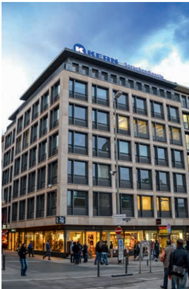
Our Frankfurt branch, Schillerstrasse 1 (Hauptwache)
